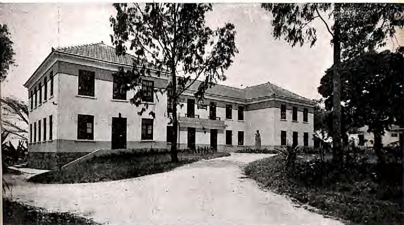
Pavilhão Simões Lopes (dormitórios, refeitórios, biblioteca, salas de administração, etc.).
